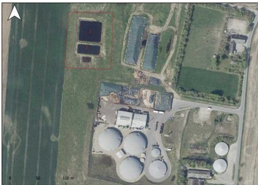
Figur 7 Forsinkelsesbassin markeret med rød firkant. Bassinet er opdelt i tre mindre bassiner som er forbundet via overløb. Vand fra anlægget kommer til bassin nr. 1 først.
