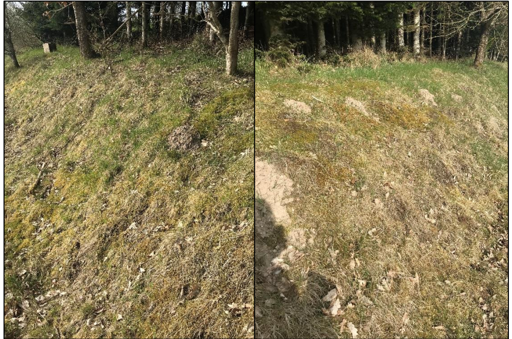
Figur 3-58 Foto fra COWIs besigtigelse den 01.05.2023. Skrænten op mod nåleplantagen.
