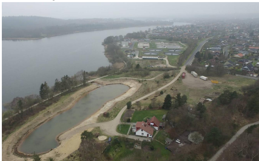
Figur 7-6 Søholt Renseanlæg set fra øst. Beplantning i renseanlæggets østlige side forventes at skulle fældes på grund af udvidelsen. Kilde: Google Maps.
