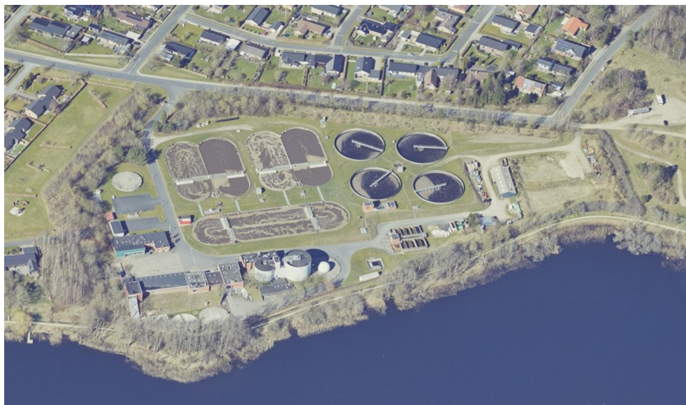
Figur 3-1 Eksisterende forhold, Søholt Renseanlæg set fra syd. I forgrunden ses Silkeborg Langsø. (COWI Skråfoto, februar 2023)
