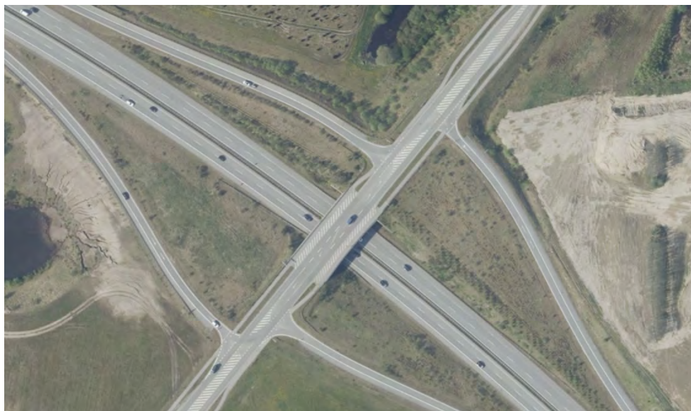
Figur 7-9 Luftfoto af krydset tilslutningsanlæg 29.
