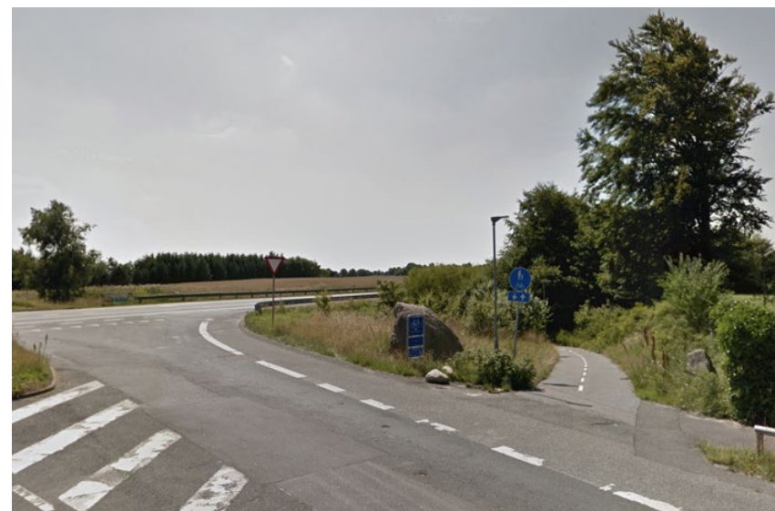
Cyklister fra viadukten har dårligt udsyn ved Funder Skolevej
