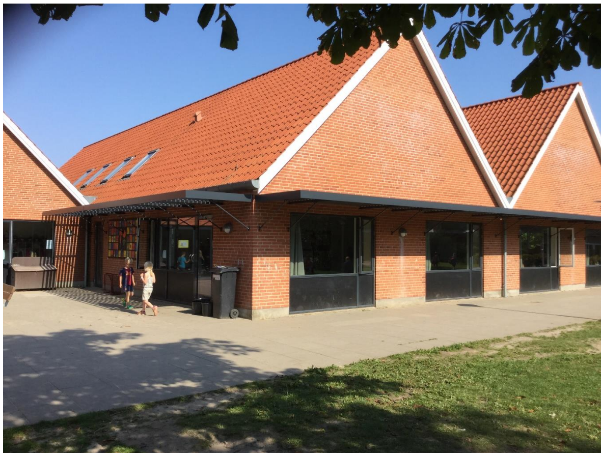
Frisholm Skole – eksempel på eftermonteret passiv solafskærmning – Farvevalget understreger bygningens markante udtryk gennem kontrast til det røde tegl
