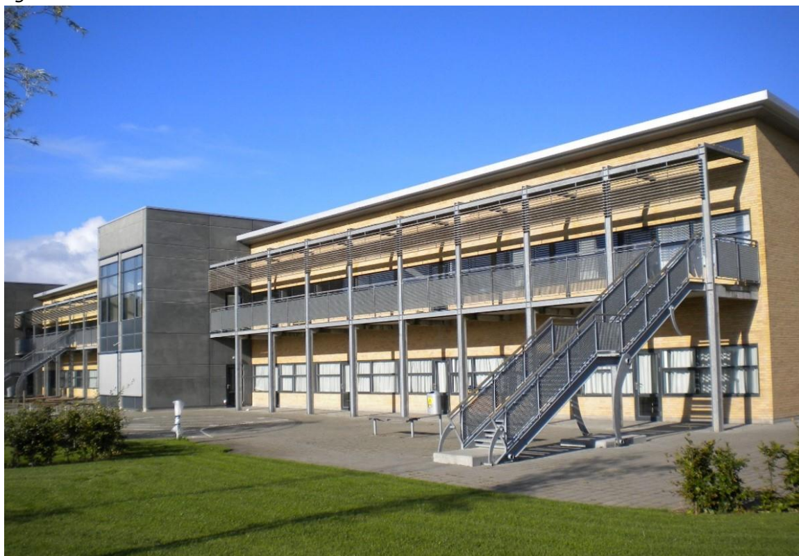
Buskelundskolen – Eksempel på passiv løsning med dobbeltfunktionalitet – solafskærmning og svalegang.
