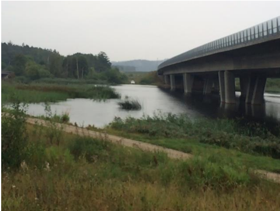
Foto: Fra besigtigelsen den 20. august set fra nordbredden mod syd. Til højre i billedet ses motorvejsbroen. Til venstre skimtes Ringvejsbroen.
